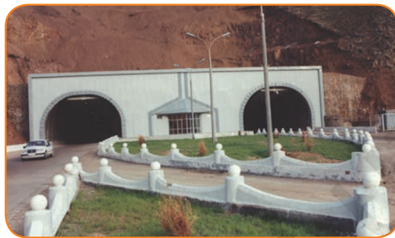
74-súwret. Qamshıq asıwındaġı tunnel.
