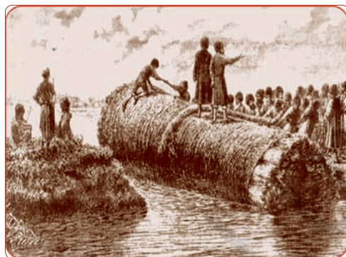
Строительство плотины. Конец XIX в.
