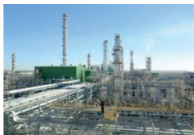
29-сүрөт. Газды кайра иштетүүчү завод.
