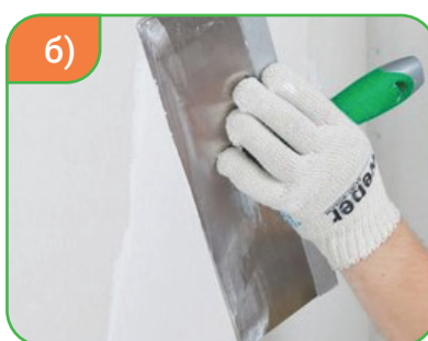
84-сүрөт. Шпаклёвка сүртүүнүн баскычтары: а) шпаклёвканы миксер менен даярдап алуу; б) шпаклёвканы сүртүү; в) кум кагаз менен тегиздөө.
