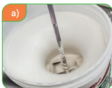
84-сүрөт. Шпаклёвка сүртүүнүн баскычтары: а) шпаклёвканы миксер менен даярдап алуу; б) шпаклёвканы сүртүү; в) кум кагаз менен тегиздөө.
