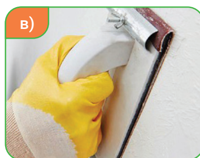
84-сүрөт. Шпаклёвка сүртүүнүн баскычтары: а) шпаклёвканы миксер менен даярдап алуу; б) шпаклёвканы сүртүү; в) кум кагаз менен тегиздөө.
