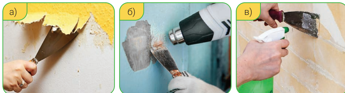
82-сүрөт. Каптоолорду тазалоо иштери: а) механикалык ыкма; б) термикалык ыкма; в) химиялык ыкма
