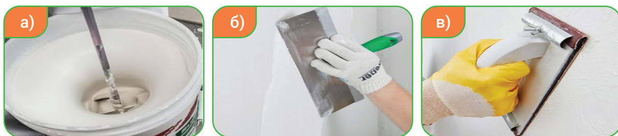
Рисунок 84. Этапы нанесения шпаклёвки: а) подготовить шпаклёвку с помощью миксера; б) нанесение шпаклёвки; в) выравнивание наждачной бумагой
