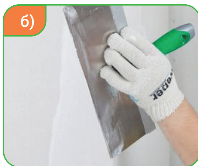
Расми 84. Марҳилаҳои гузоштани шпаклёвка: а) бо миксер шпаклёвка тайёр кардан; б) гузоштани шпакловка; в) ҳамвор кардан бо коғаз.
