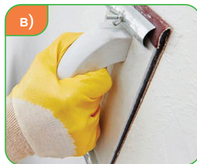
Расми 84. Марҳилаҳои гузоштани шпаклёвка: а) бо миксер шпаклёвка тайёр кардан; б) гузоштани шпакловка; в) ҳамвор кардан бо коғаз.
