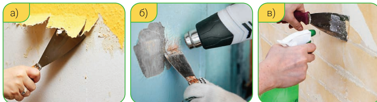
Расми 82. Усулҳои тоза кардани рӯйпӯшҳо: а) усули механикӣ; б) усули термикӣ; в) усули кимёвӣ.
